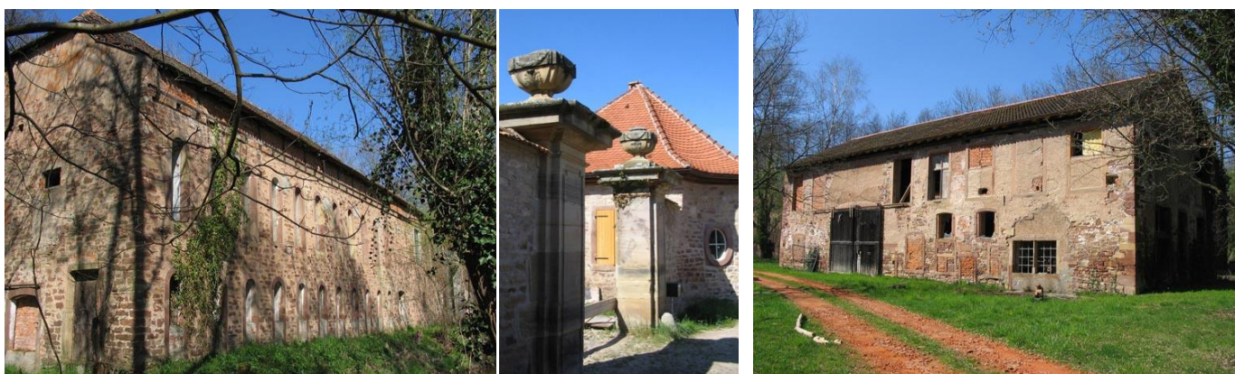
Bâtiments (briqueterie et papeterie) du Domaine Pasquay – Source : Tourisme67
