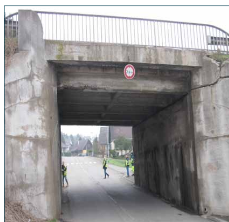
Pont vers le lotissement Osterfeld
